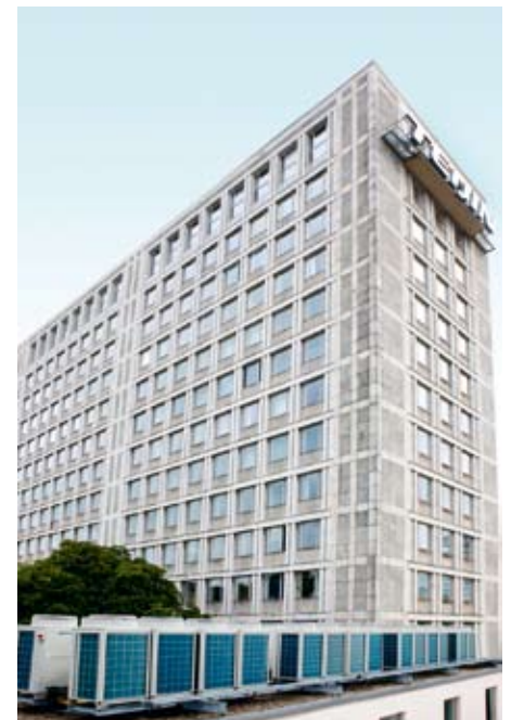
Nach der Übernahme durch den japanischen Chemiekonzern Teijin wurde das Hochhaus energetisch saniert. Das Bild zeigt die Außengeräte City Multi VRF von Mitsubishi Electric
